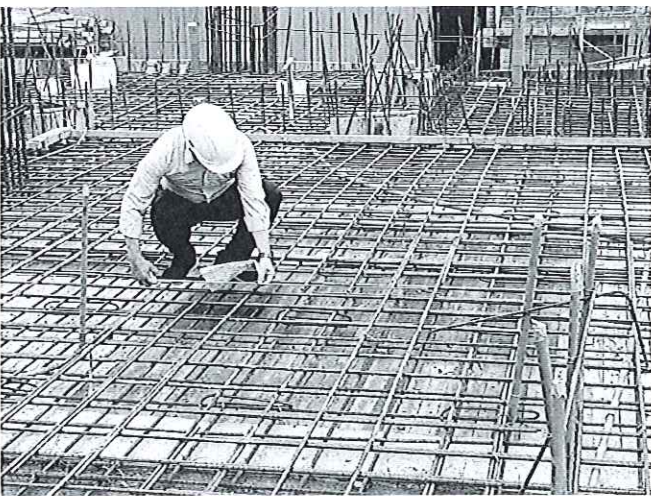
灌漿前結構技師勘驗
