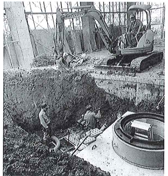
台電配電移箱開挖
