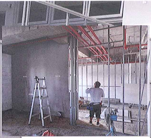
室內輕隔間安裝
