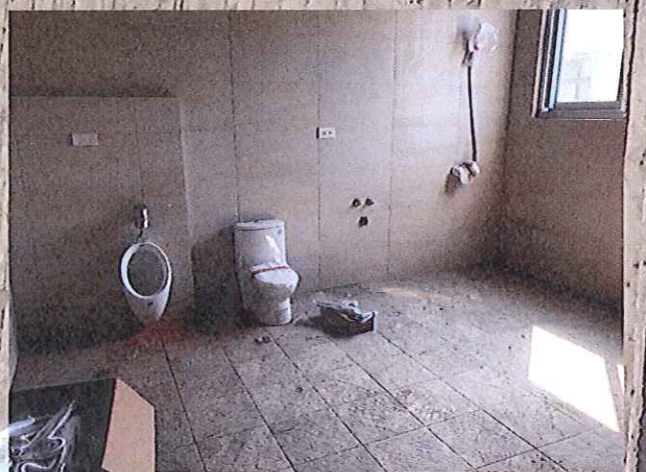
浴廁馬桶安裝完成
