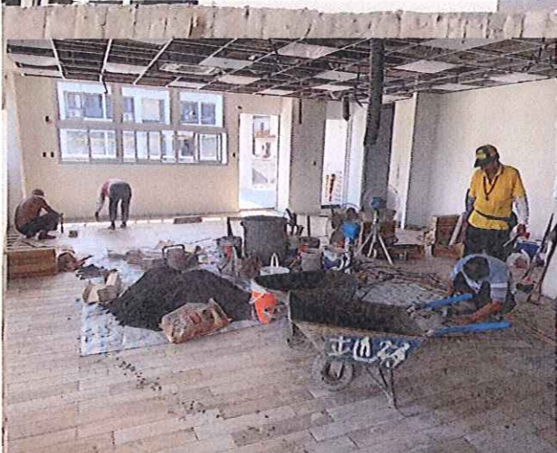
室內地磚鋪設
